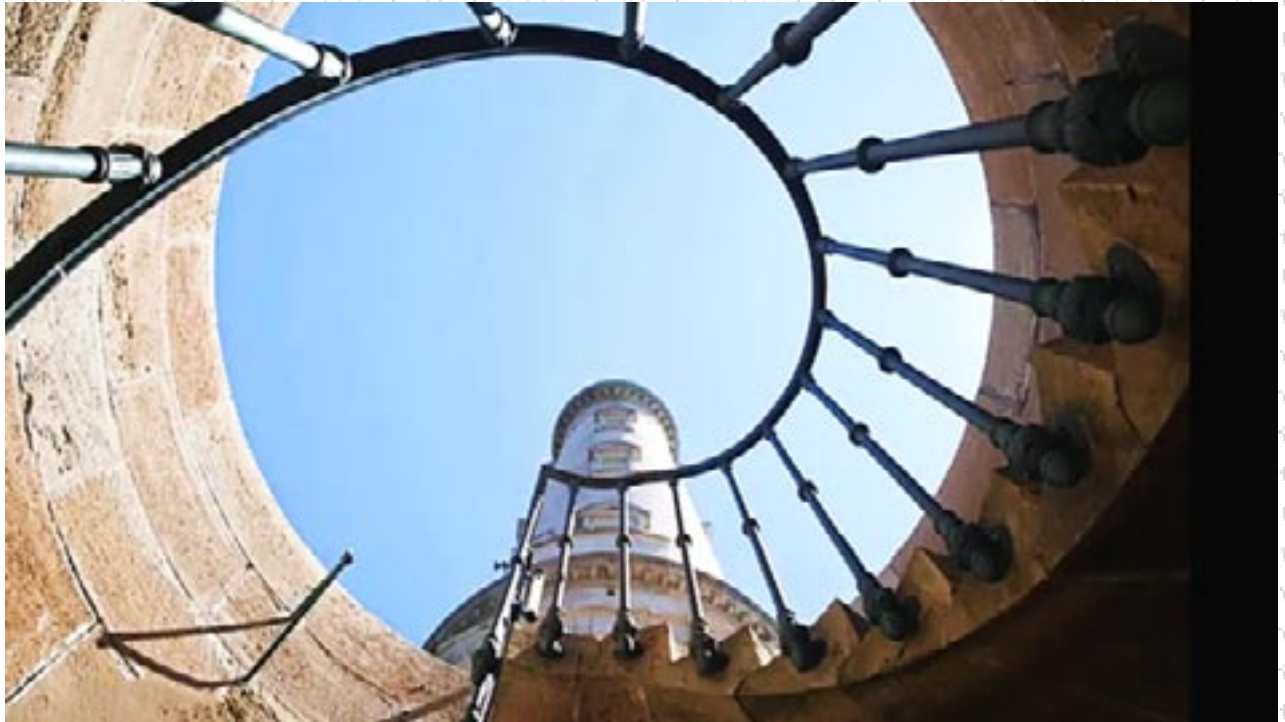
Escalera interior del faro de Cordouan.
